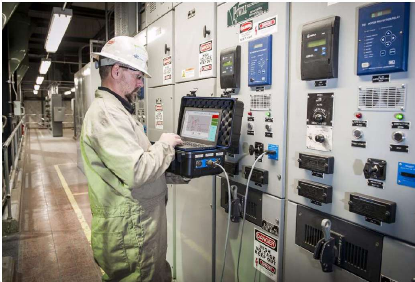
Техник работает с анализатором EXP4000, подключенным к порту блока связи EP1000 на шите управления МСС.
