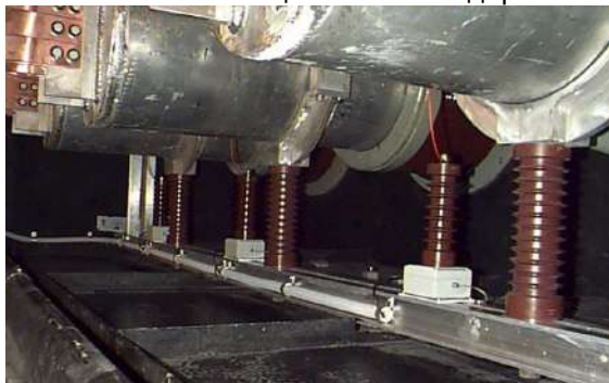
Рис. 1: Установка снятия сигнала на постоянной основе
