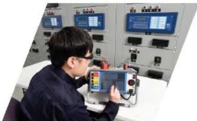
Испытание одно и трехфазных устройств релейной защиты
