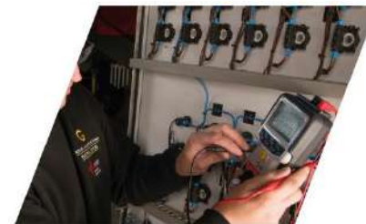
Проверка низковольтных инсталляций
